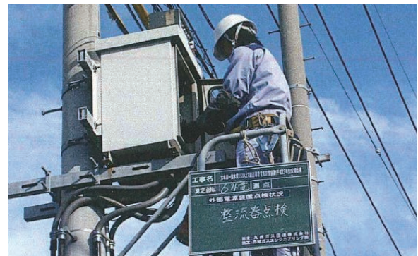
外部電源装置の点検
