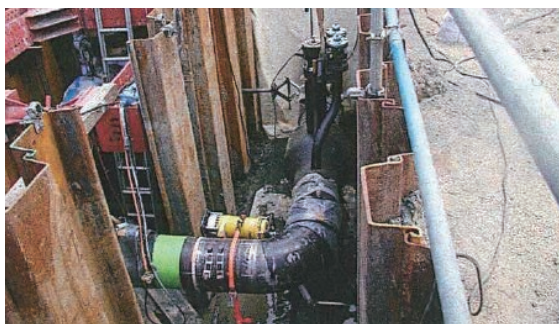
導管移設工事
