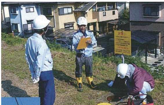
導管の電位測定
