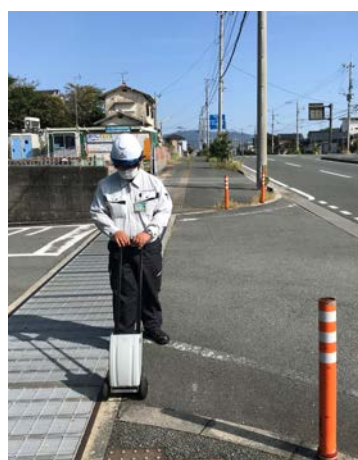
埋設管ガス漏洩検査
