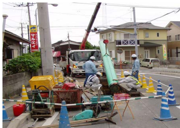
延伸導管埋設工事
