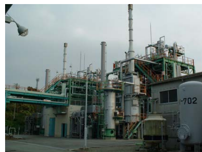
旧三井鉱山化成（株）SNG 製造設備
