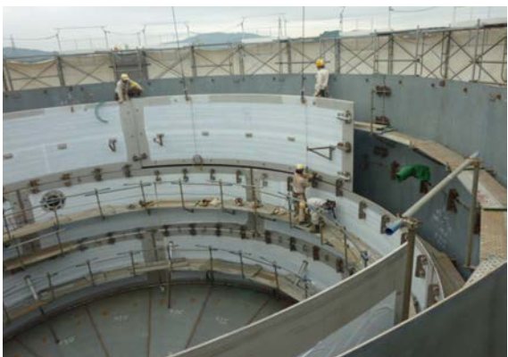
建設中の LNG タンク内部
