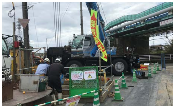
諏訪川ガス導管移設推進工事
