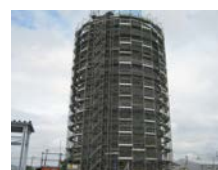
建設中の大牟田工場 LNG タンク
