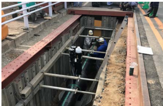
バルブ新設工事
