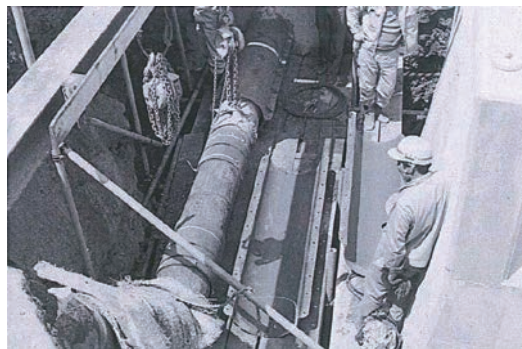
導管建設工事
