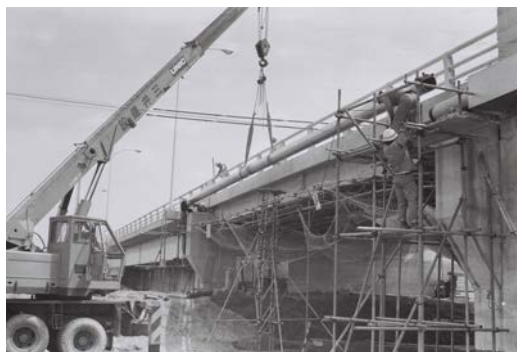
導管建設工事
