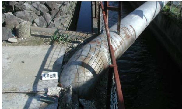
農業用水路上の露出管
