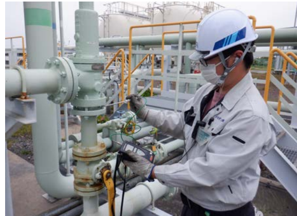
ガスの漏えい点検
