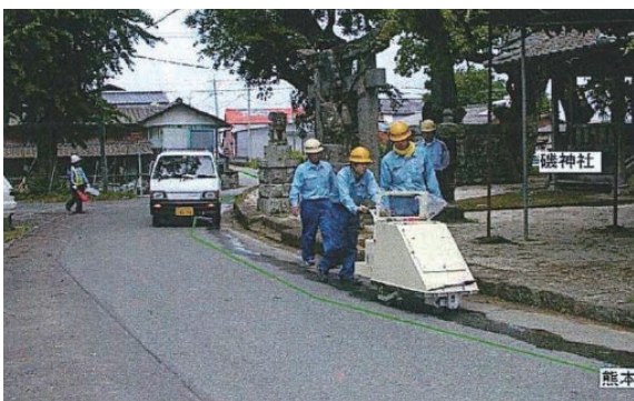
スーパーコーディエンス法による埋設管腐食検査
