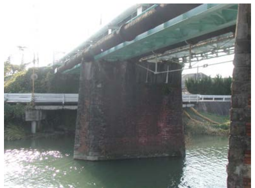
諏訪川旧鉄道橋添架管
